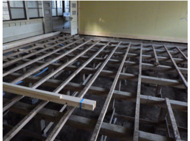
床張り替え中
