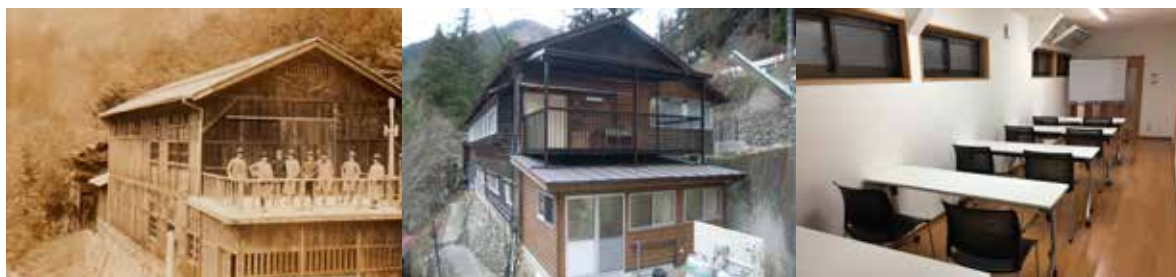
往時と現在の外観と新設されたミニ講義室
