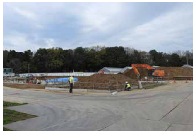
総合研究実験棟基礎工事の様子（背景は田無演習林の森）
