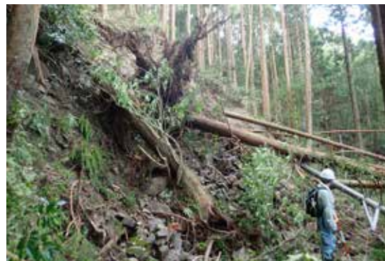
法面崩壊によって土砂と倒木に覆われた一杯水林道（千葉）
