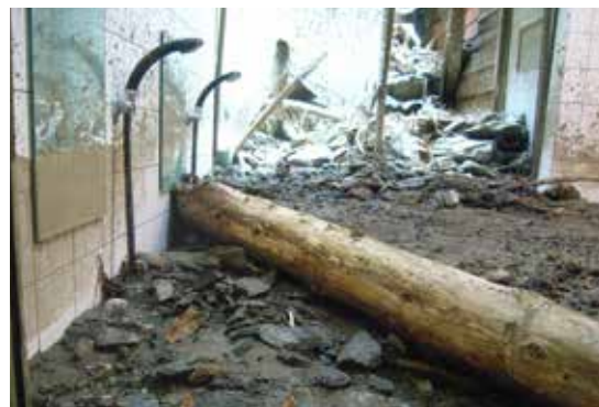
土砂が流入した川俣学生寄宿舍の浴室（秩父）
