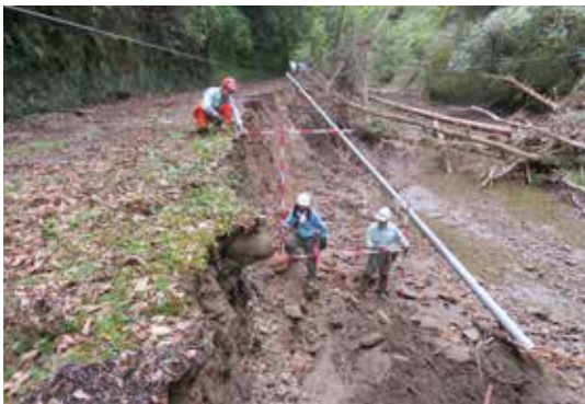
豪雨によって路肩部分が流失した猪ノ川林道（千葉）
