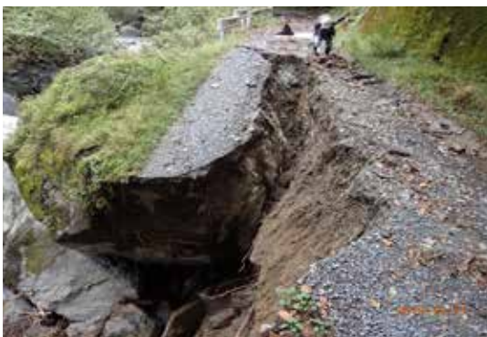
入川林道始点付近で発生した路肩崩壊（秩父）
