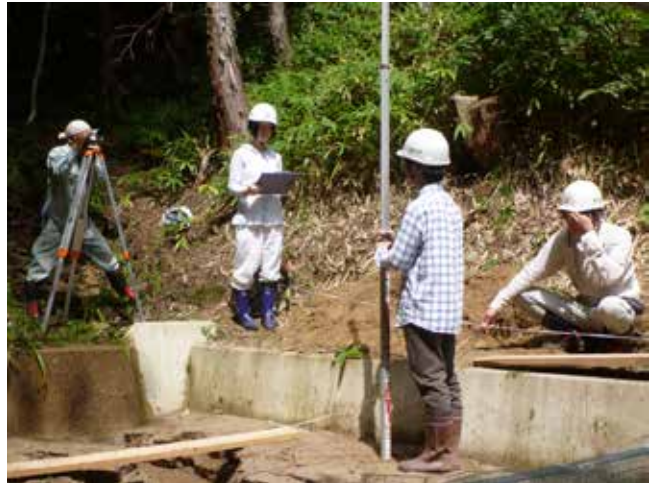
量水堰で砂出し前の測量をする参加者
