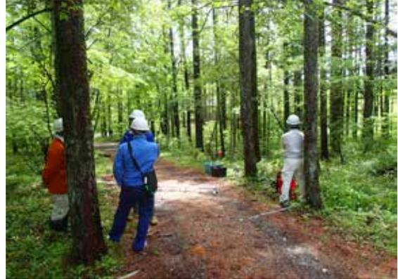
ポータブルロープウィンチを用いた伐倒作業
