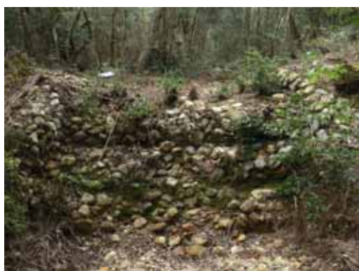
土壇堤工に設けられた鉄線蛇籠製の放水路（1930年設置）
