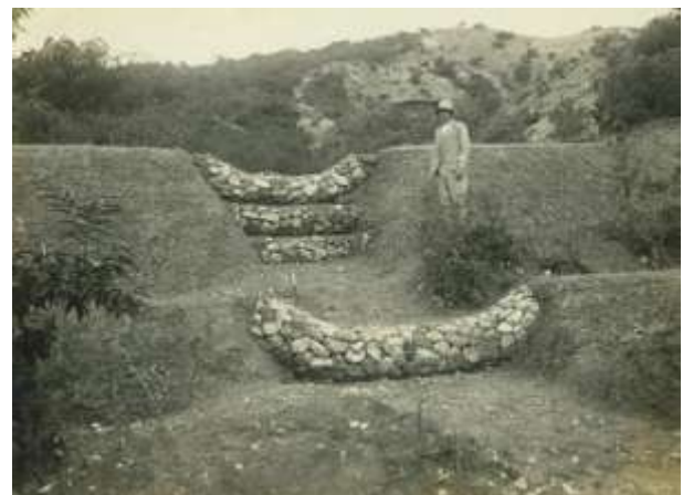
1929(昭和4)年に作られた当時の土壇堤
