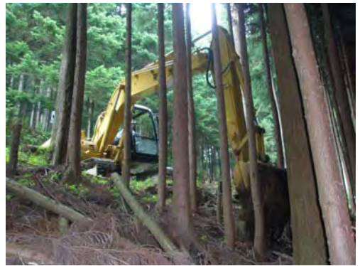
バックホウによる掘り取りの様子 切り株に傷をつけないように丁寧に作業するため、非常に高い技術が要求されます。
