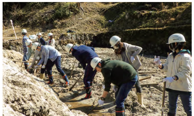
写真3 学生による堰堤内砂出し作業
