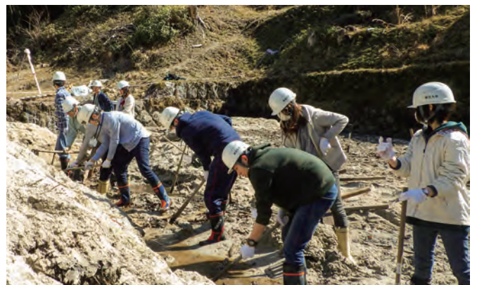
写真3 学生による堰堤内砂出し作業
