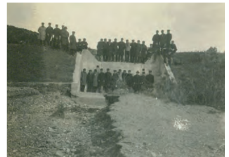
写真7 コンクリート放水路付土堰堤(1929年撮影)
