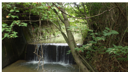
図-9 現在の八床川 2022 年 9 月 15 日撮影、コンクリート三面張りの川になっている、川の中央付近に中央小幅ノッチがあったと考えられる。
