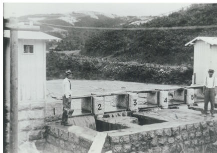
図-2 穴の宮量水堰 1925 (大正 14) 年 8 月 16 日
