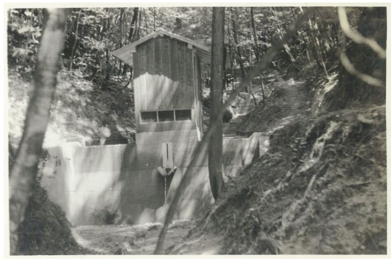
図－4 昭三十三・八・二十三・写・白坂 地下水測定堰堤 北谷 https://electra.lib.a.u-tokyo.ac.jp/eri/jpeg/23/23_0088.jpg
