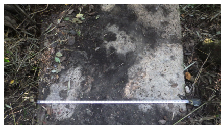
図-5 数成量水堰の一部の上部 2022 年 9 月 26 日撮影、上流側 (写真左側) は 厚さ 3cm のコンクリート板、下流側 (写真右側) は目地がコンクリートの石組みで出来ている。
