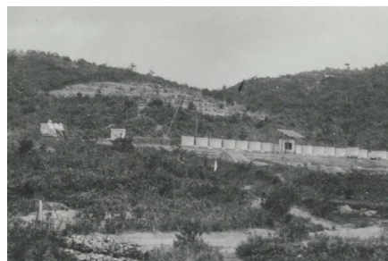
図－22 観測当時の穴の宮浸透試験の様子 1929 年 8 月 18 日撮影（生水研アーカイブス） 鉢が奥に固められており、左側に 3 人で鉢を押す姿が見える。
