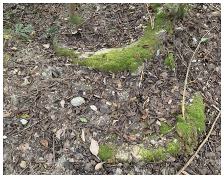
図-27 大鉢の底に使われたコンクリート板 2022年10月27日撮影。
