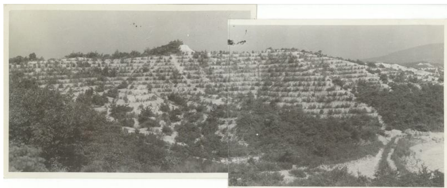
図－1 昭31.8.16 南山中学西 法切勾配に関する試験地
