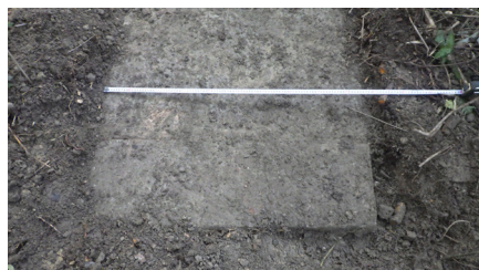
図-6 数成量水堰の一部の右岸側 2022 年 9 月 26 日撮影、上流側から下流側ま でつながった石でできており、角は垂直に成型 されていることからノッチ部分であることがわ かる。
