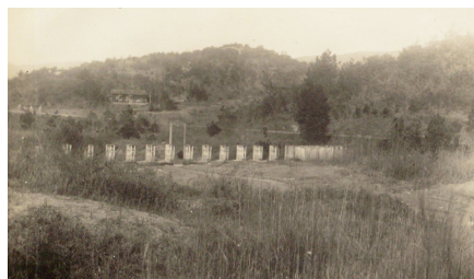
図－2 観測終了後の数成量水堰静水池 1949年1月11日撮影（生水研アーカイブス） 静水池は土砂で埋まり、観測小屋が撤去されている。
