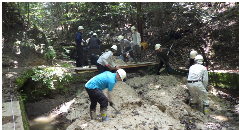
図－26 北谷量水堰の砂出し作業
