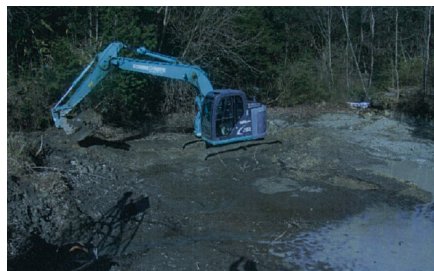
図－10 重機を使った穴の宮量水堰砂出し作業 2015年（平成27年）
