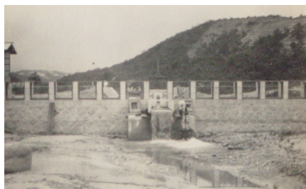
図-1 数成量水堰、量水槽の排水の様子 1930 年 8 月 20 日撮影(生水研アーカイブス) 奥の山に法切工による砂防植栽の様子が見える。
