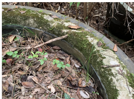
図-26 現存する穴の宮浸透試験の大鉢の上部拡大写真 2022年10月27日撮影、土管の淵の部分がコンクリートで固められている。
