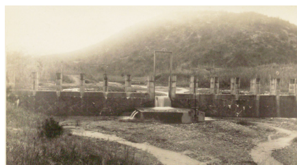
図－3 観測終了後の数成量水堰下流部 1949年1月11日撮影（生水研アーカイブス） 量水堰下流部にも多くの土砂が堆積しており、ノッチの金属部分等が撤去されている。
