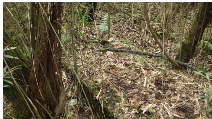
図-4 数成量水堰の一部 発見時の様子 2022 年 9 月 15 日撮影、あたり一面ササの中、 落葉に覆われた幅1mの構造物が見つかった。
