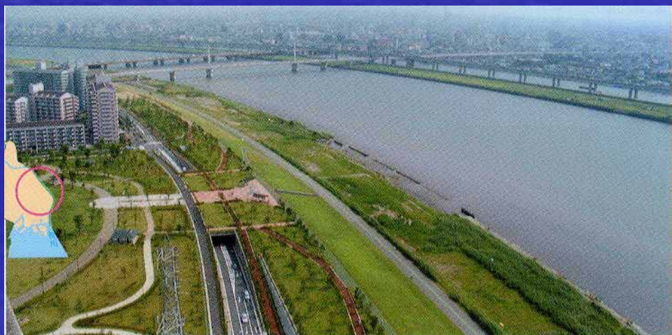
小松川付近 (河口より4.0km付近 江戸川区)
