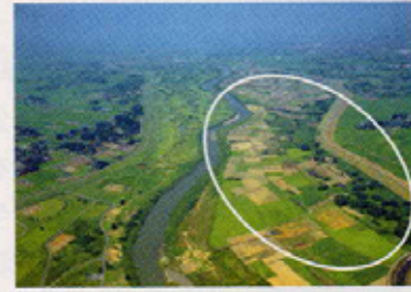
糠田橋上流付近上空より
