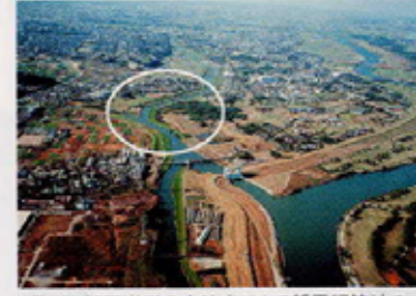
荒川と新河岸川の合流点にある朝霞調節池の周辺は、水害の起きやすい地域でした。
