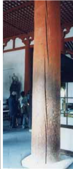
左下の写真は回廊の柱(長さ3m、太さ38cm) 芯去り材のため、胸高直径120cm以上の材を使用したものと考えられる。
