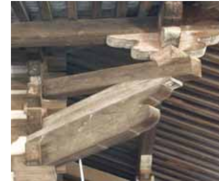
下の写真は中門雲肘木(長さ4m) 長さ5m、末口径80cmの丸太が必要
