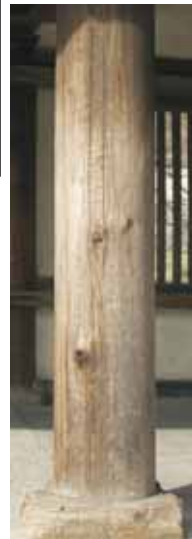
左下の写真は回廊の柱(長さ3m、太さ38cm) 芯去り材のため、胸高直径120cm以上の材を使用したものと考えられる。
