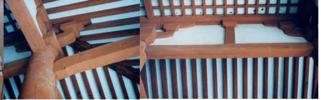
下の写真は中門雲肘木(長さ4m) 長さ5m、末口径80cmの丸太が必要
