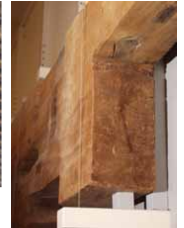
左下の写真は回廊の柱(長さ3m、太さ38cm) 芯去り材のため、胸高直径120cm以上の材を使用したものと考えられる。
