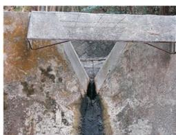
測水所は山中にあるため、ノッチに落葉落枝が引っかかり、水位が降下しない場合が多々ある。写真左のように金網などを貼ってゴミが溜まりづらいうようにしたり、週1回の観測時にゴミを取り除くようにしている。
