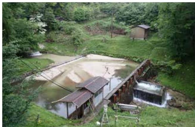
強い雨により多量の土砂が流れ込んだ白坂量水堰堤
