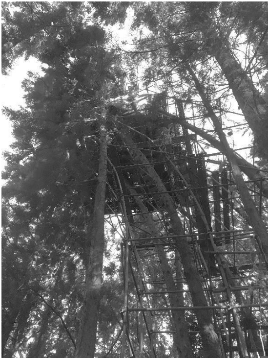
台風24号の強風により傾斜した観測鉄塔
