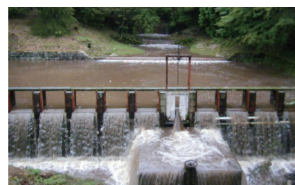
写真4 生態水文学研究所白坂量水堰。1929年から90年以上のデータが蓄積されている。
