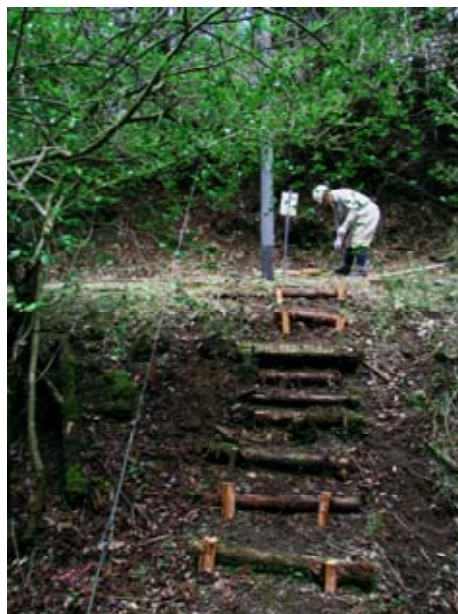
お弁当広場の階段補修
