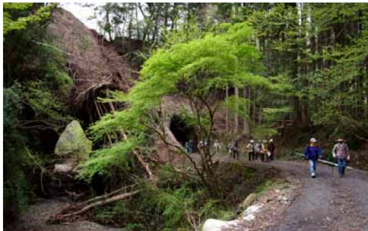
崩壊した滝ノ沢
