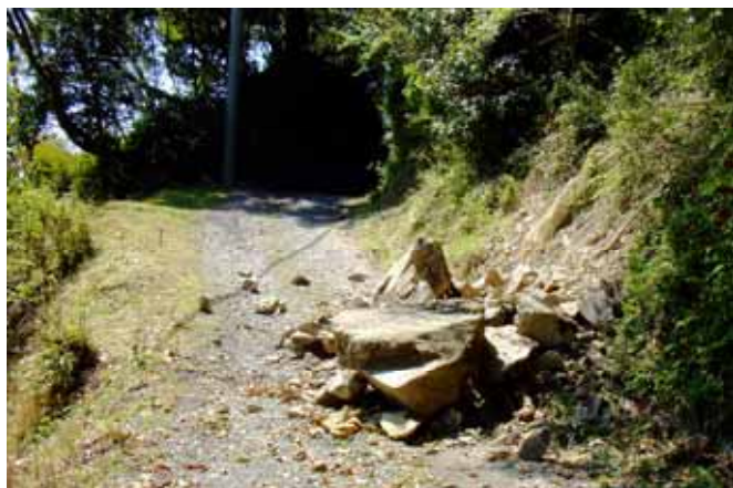
通行不能になってしまった林道
