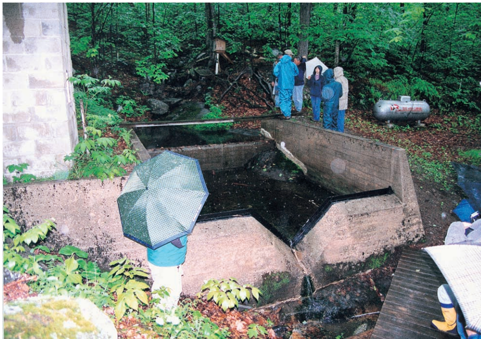
写真3.1.2 ハッバードブルック試験流域の水流出量測定堰。2001年5月27日，筆者撮影
